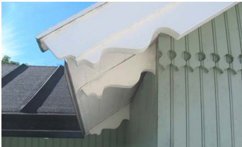
Vackert bearbetad takfot och dekorativt gavelstycke i pärlspånt på en av kolonistugorna. Taket klätt med tjärpapp monterat på trekantlister.
