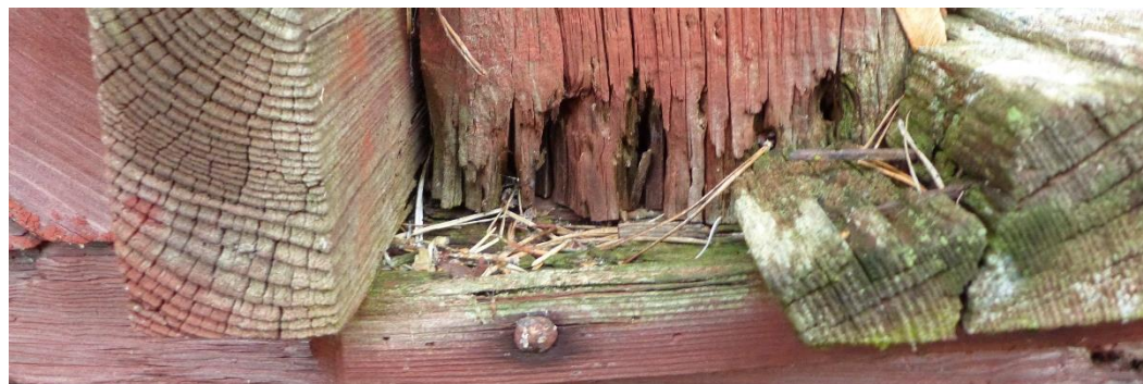
Figur 10. Närbild på slitaget där trappträets fot möter trappan.
