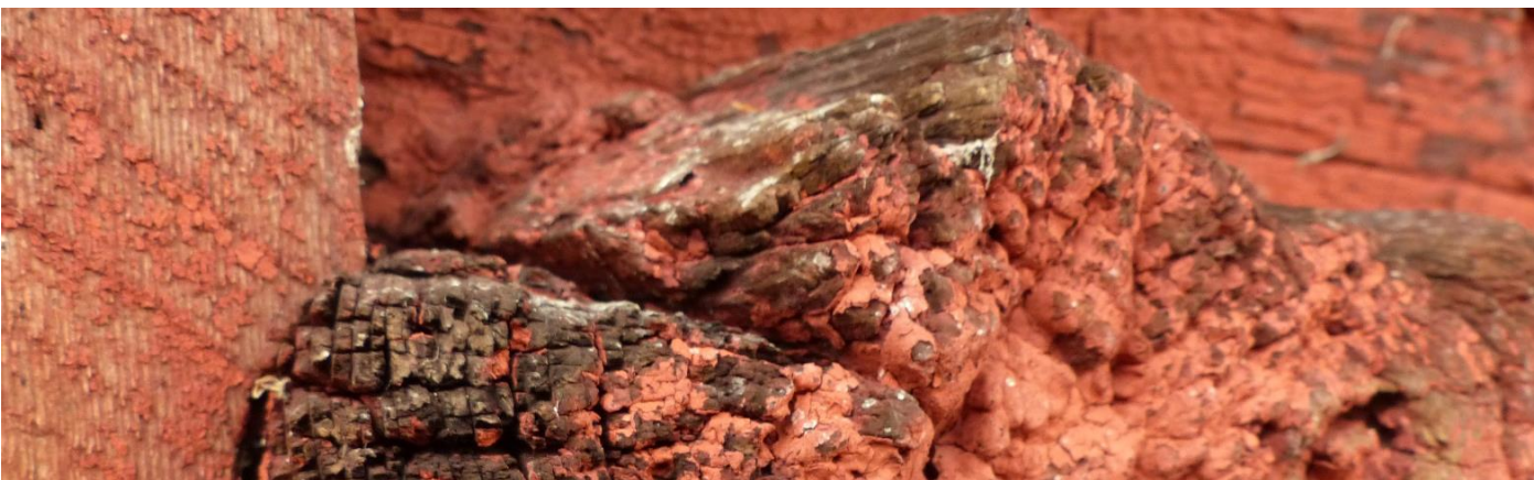
Figur 7. Närbild av timmerknot som lider av röta.
