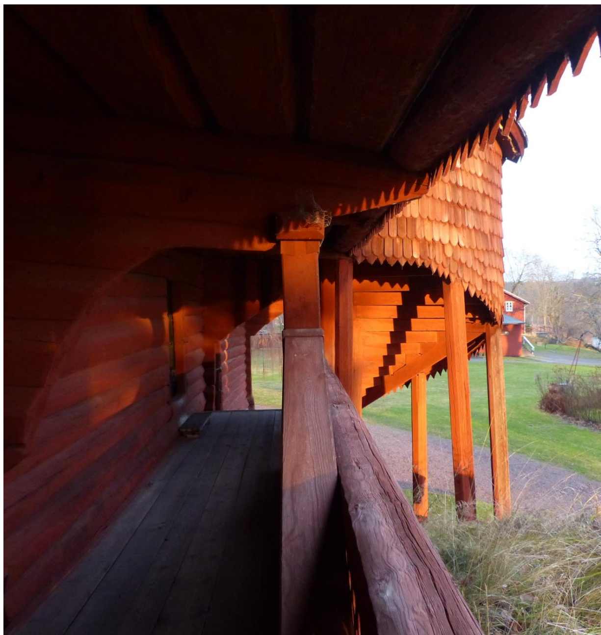
Figur 8. Stödpelare för den övre svalgången, trappan ses i bakgrunden.
