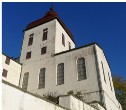
Slottskyrkan på Läckö slott restaureras med hjälp av det utökade bidragsanslaget – puts av fasad, tätning av skiffertak och renovering av takspiror. Foto: SFV/Olle Nylind
