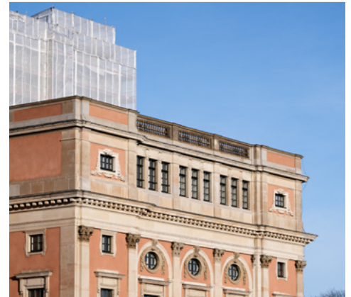
Regeringen ger SFV klartecken att förbereda för renovering av operabyggnaden. Foto: SFV/Johan Bernes
