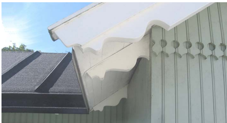
Vackert bearbetad takfot och dekorativt gavelstycke i pärlspont på en av kolonistugorna. Taket klätt med tjärpapp monterat på trekantlister.
