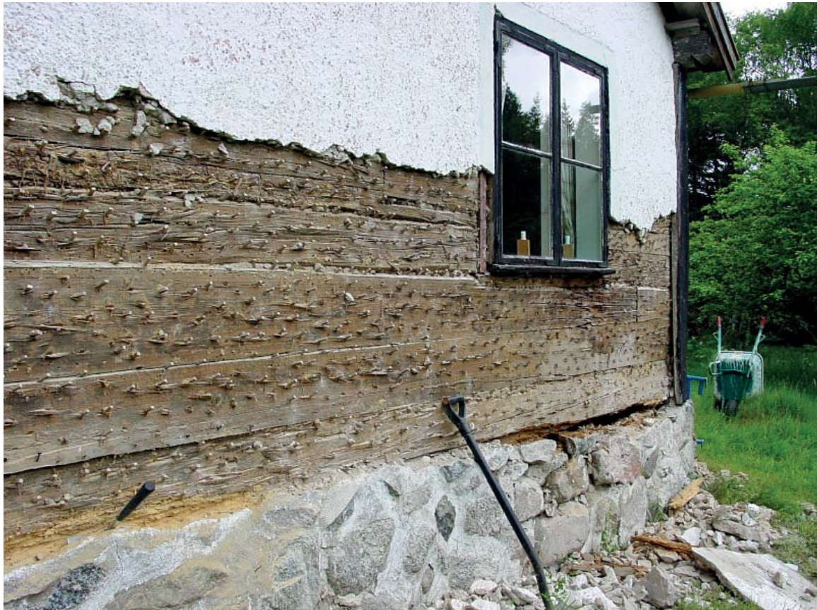
De små träpluggarna i timmerväggen håller reveteringen på plats.
