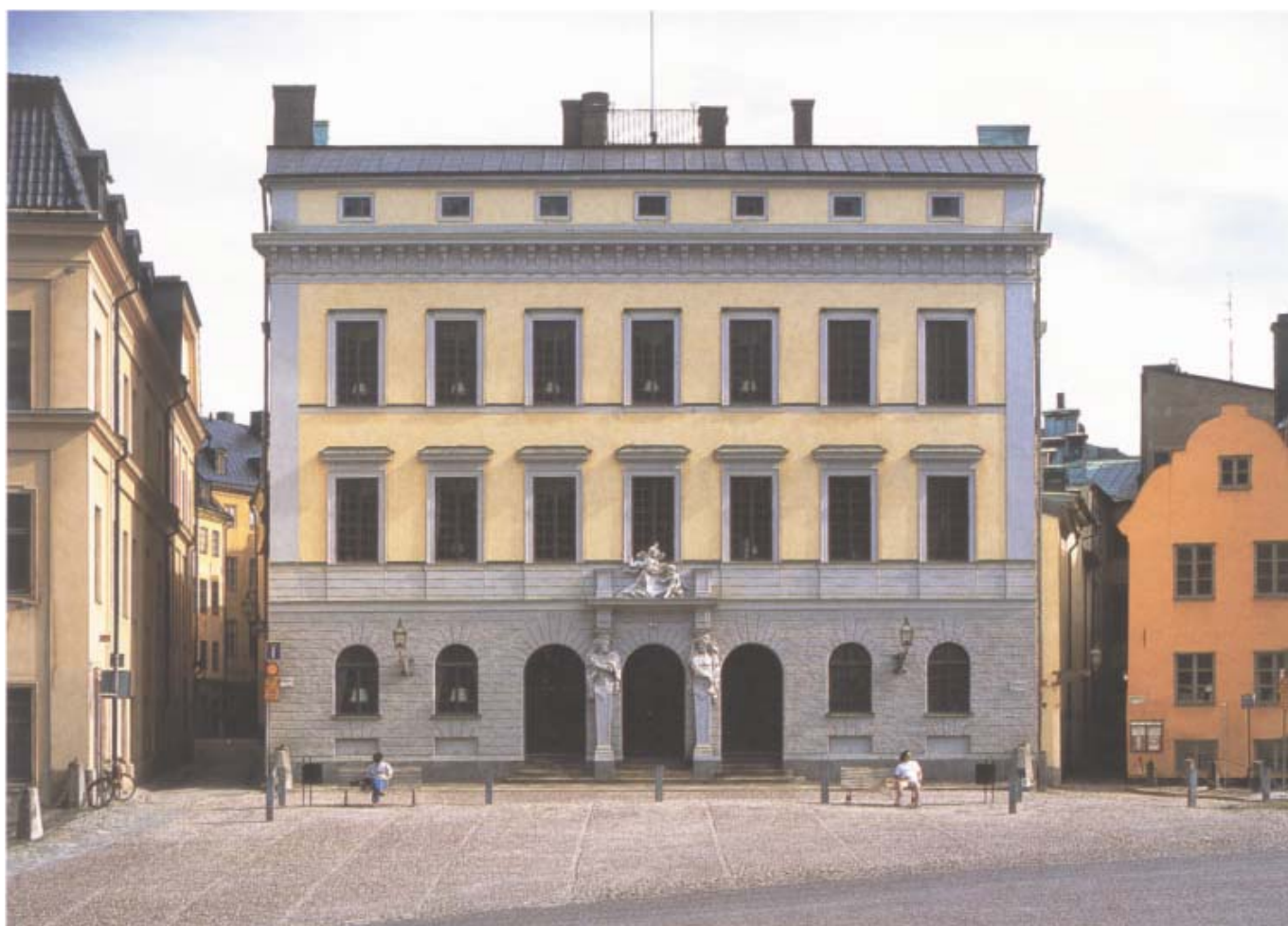
Palatset har återfått sin ursprungliga ljusa fasad. Stenarbetena är målade med grå oljefärg.
