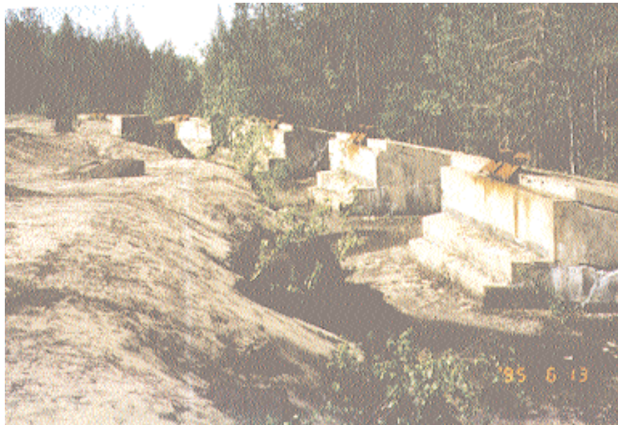
Leåkersbatteriets öppna vallgång med kanonplatser och pansarplåtar för gevärsskyttar.
