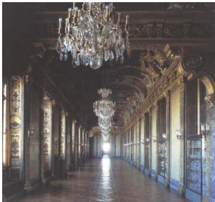
Osynliga högkänslighetsdetektorer installeras bland annat i Karl XI:s galleri, ett av slottets stora paradrum.
