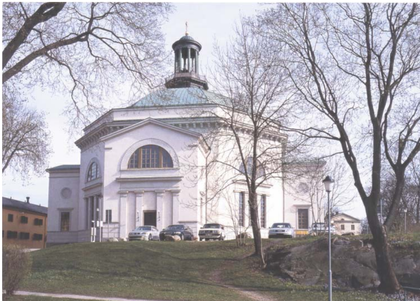
Kyrkan återfick sin ljusa kulör i samband med Fastighetsverkets fasadrenovering 1998.
