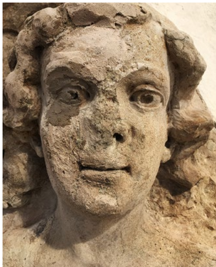
När residenset i Karlskrona renoverades 2018 var entréportalen i neobarock väldigt trasig, som detta ansikte där stora delar vittrat bort. Att hugga nytt var ett alternativ, om än dyrt, så Svante Nilsson fick uppdraget att rekonstruera med specialtillverkat lagningsbruk som innehåller cement, akrylat och marmormjöl.
