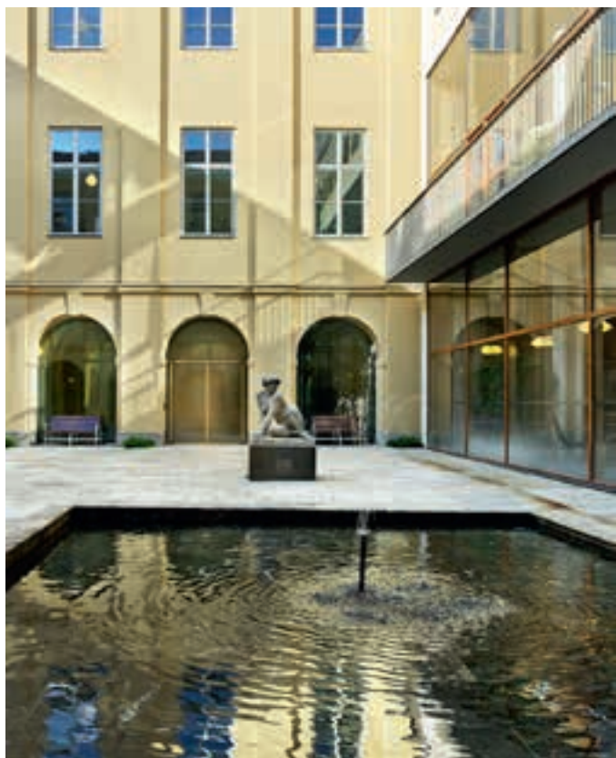
Valvöppningarna mot gården har fått nya glaspartier, vilket binder samman de båda huskropparna på ett tydligare sätt.
