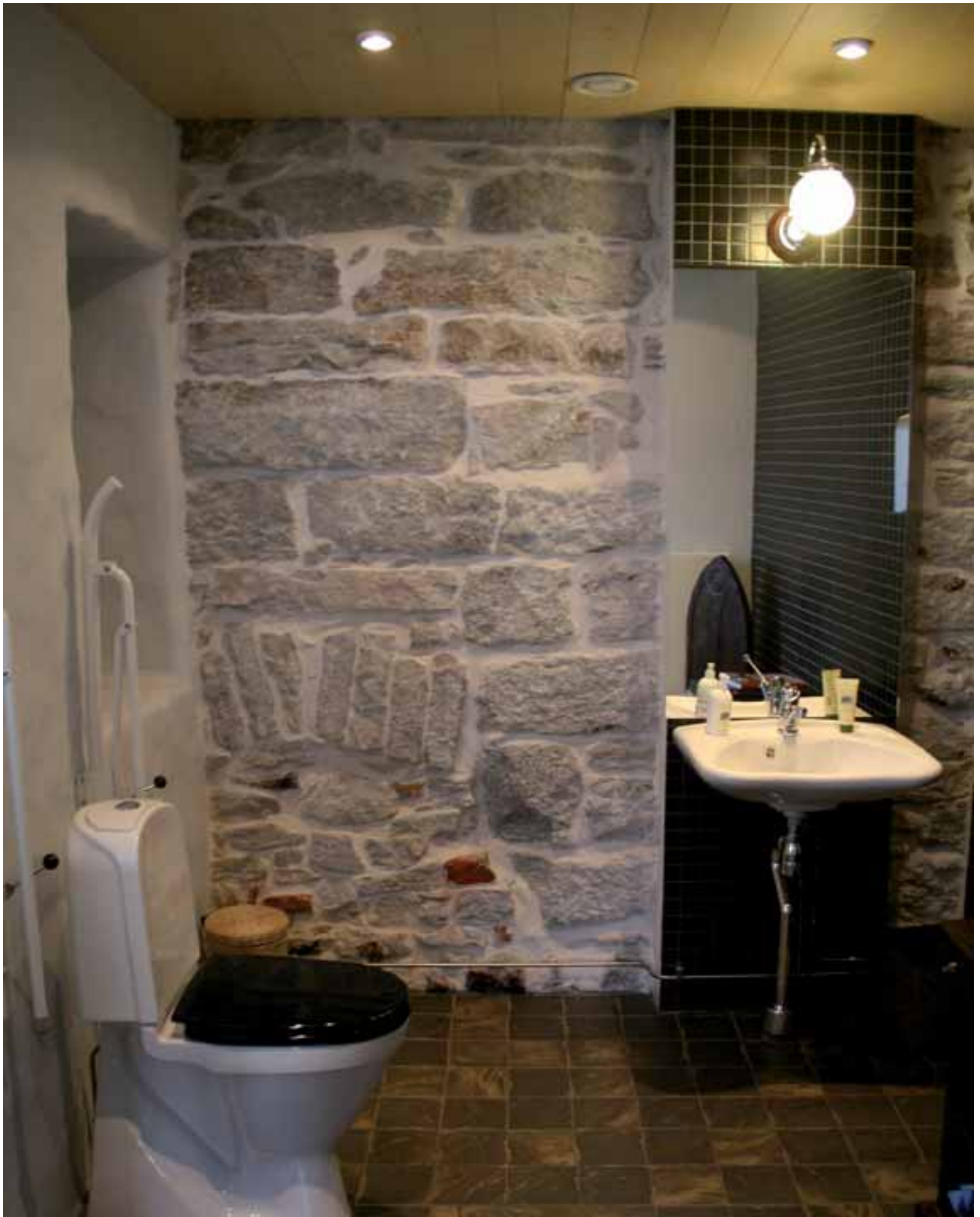
I den frilagda stenväggen i toaletten innanför loungen visade sig spåren efter en igensatt äldre källarnedgång.
