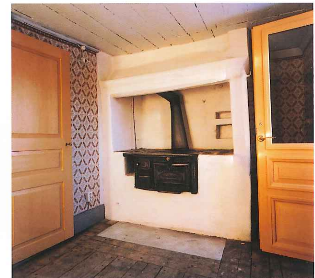
Bellmanshusets största köksspis, med en magnifik järnspis från Bolinders i nyrenässansstil. T.h. en specialritad, glasad spegeldörr, som harmonierar med de befintliga utan att imitera dem.
