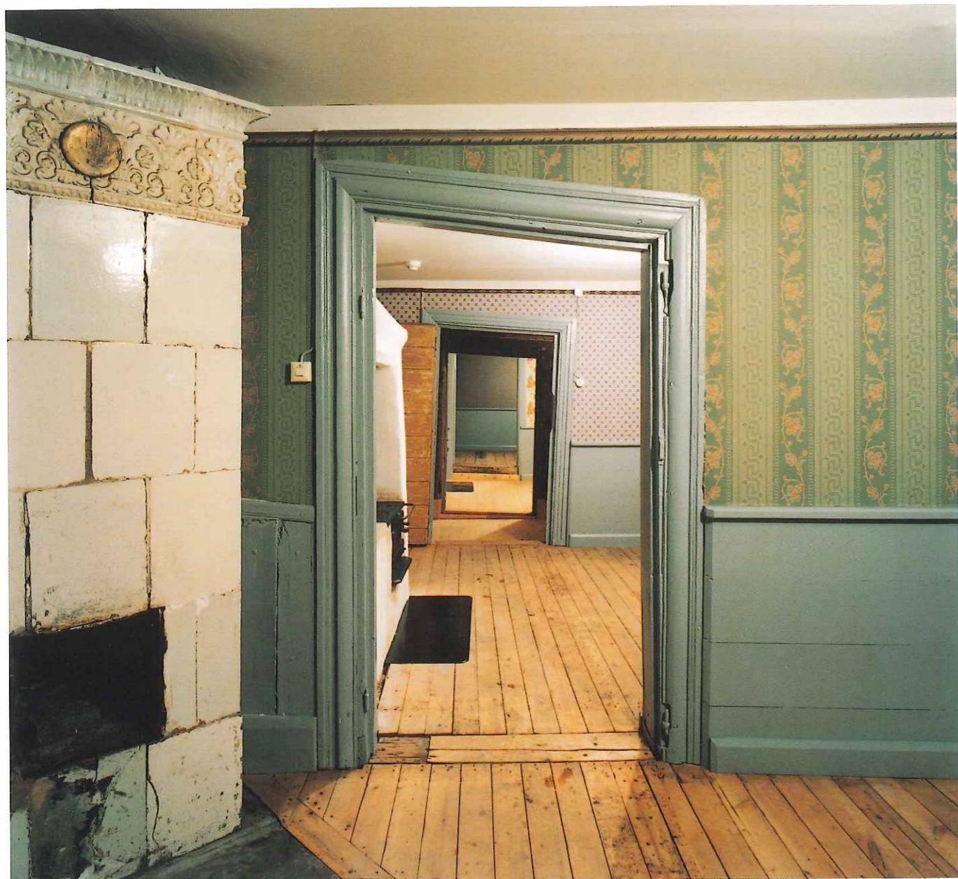
Restaurering på 1960-talsvis, med allt uppriktat och vinkelrätt – så när som på den gamla dörröppningen.
