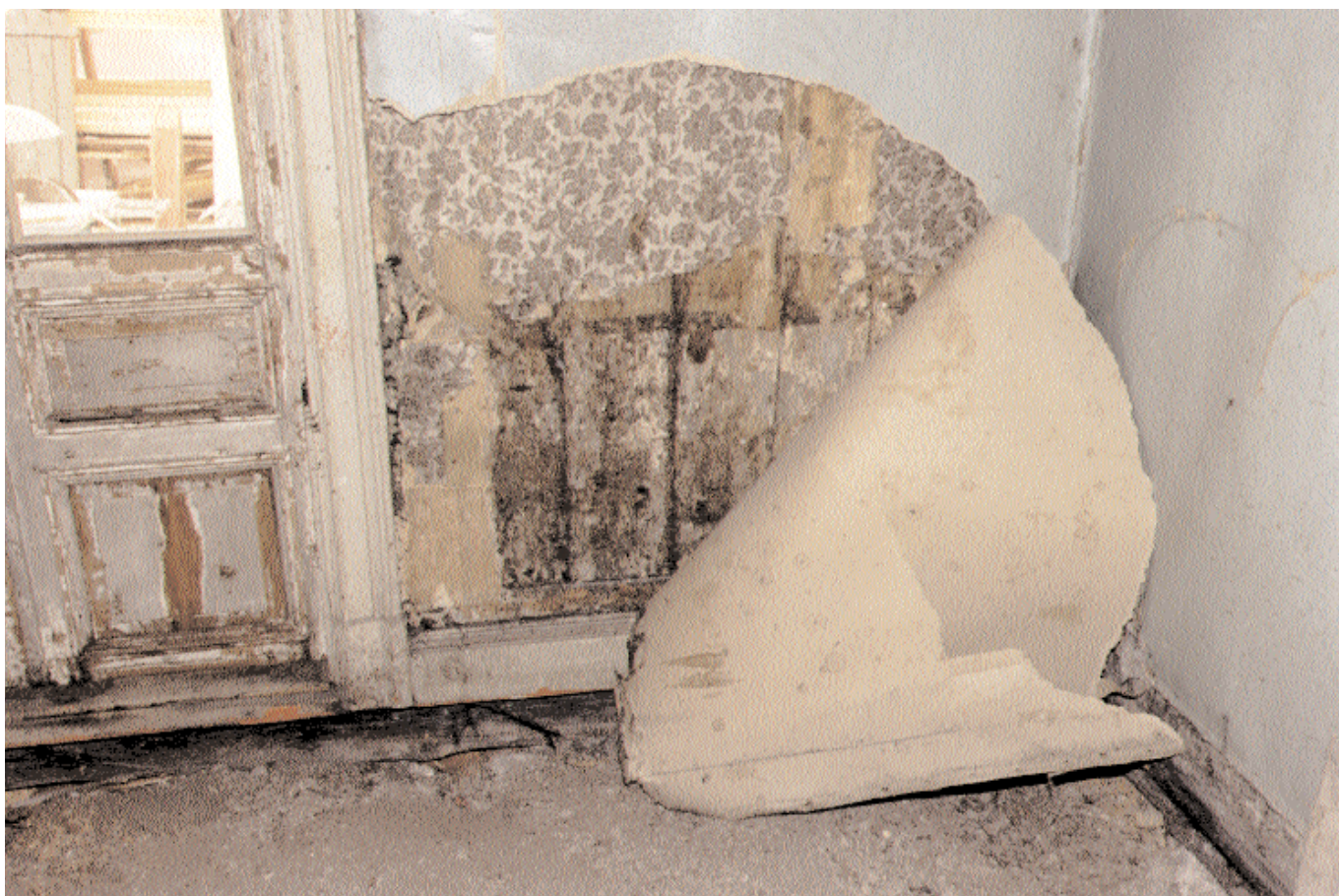
Under nyare tiders ytskikt kunde husets tapethistoria rullas upp i lager på lager ända in till de stänkmålade brädväggarna med sina målade bröstningar.
