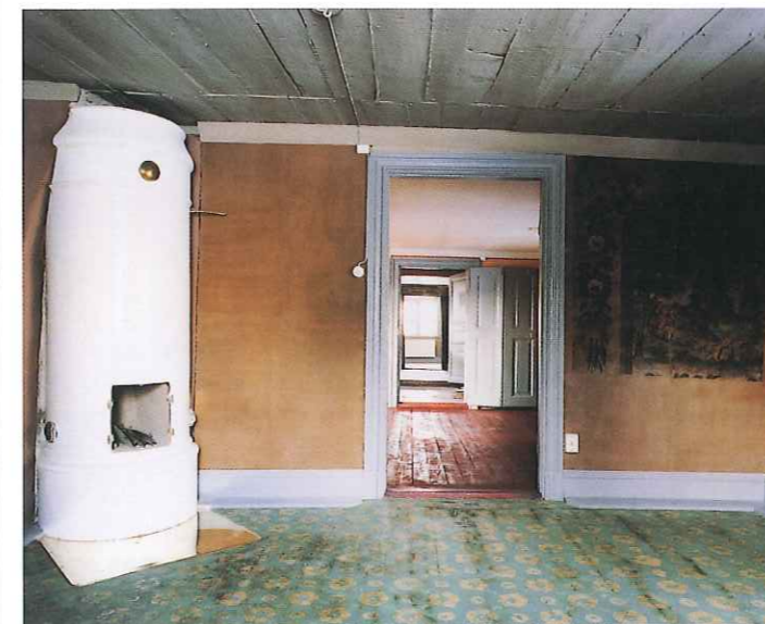
Rummet med de figurmålade vävtapeterna efter restaurering, med sin jugendkakelugn och mönstrade linoleummatta. Bortom dörren syns – sedan den igenbyggda dörren öppnats – den återigen kompletta genomsikten i fil.
