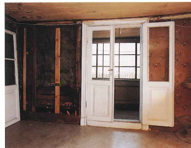
Mellanvåningens södra gavelrum när den ursprungliga – och som det sedan skulle visa sig – figurmålade väven just börjat friläggas. Observera den fina funkistapeten t.h. om glasdörren (den finns bevarad under målad papp på murstocken).
