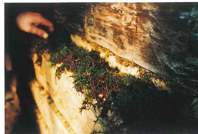
Alla lagningar utfördes med samma material och metoder som när husen byggdes. Mellan timmerstockarna tätades exempelvis med nyplockad husmossa.
