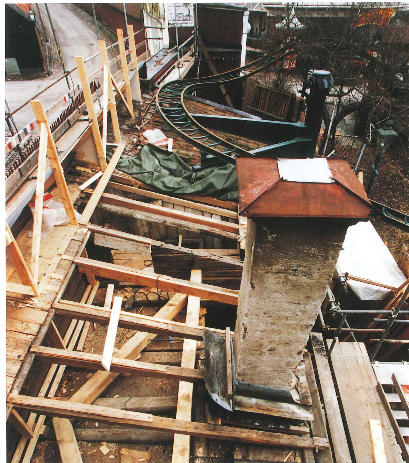
Den liggande spännbocken på Låga längans vind, som gjorde att man kunde bevara den lutande murstocken i originalskick. I bakgrunden barnens berg och dal-bana, för vars skull längans ena skorsten revs för ett antal år sedan.
