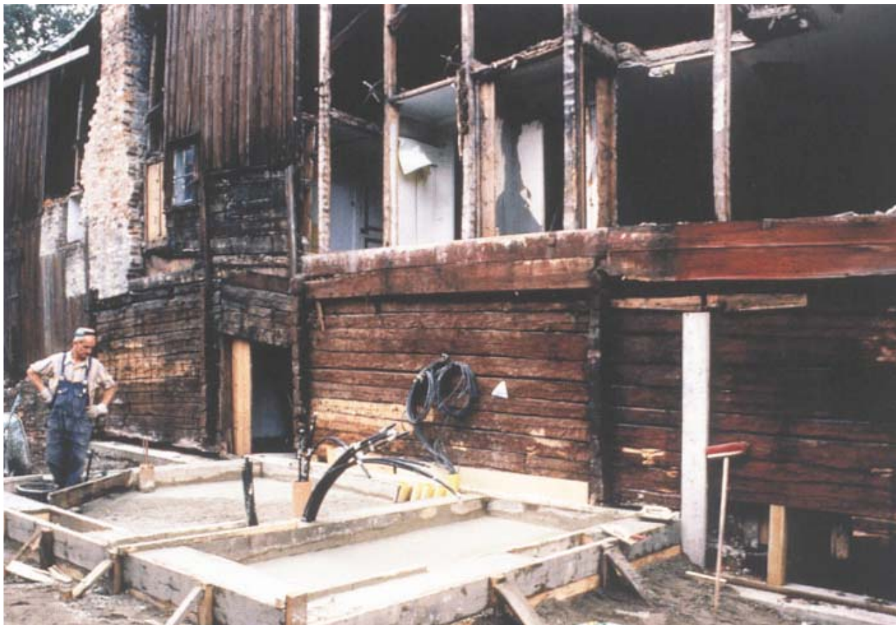
Gården Mäster Mikaels Gata 10 renoverades 1978–80 av AB Stadsholmen under överinseende av Stockholms stadsmuseum. Trots de kulturhistoriska ambitionerna innebar byggnadsnormerna att ganska stora avvikelser från de rent antikvariska hänsynen gjordes. Här gjuts grunden till ett nytt uthus för elcentral på grannfastigheten Mäster Mikaels Gata 8.
