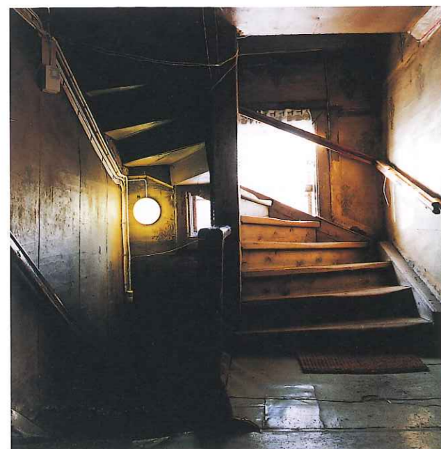
Trapphuset, med sina dekorationsmålningar från 1890-talet – här före restaureringen – har lämnats orört, så när som på att fula elinstallationer rensats bort.
