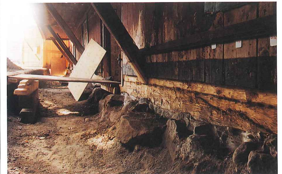
De ruttna syllstockarna har bytts ut och isolerats mot stengrunden på traditionellt sätt med näver. I timmerskarvarna har man åter tätat med husmossa eftersom det fungerat bra i 250 år hittills. Utan gatusänkningen hade dock förruttnelsen redan åter varit igång.
