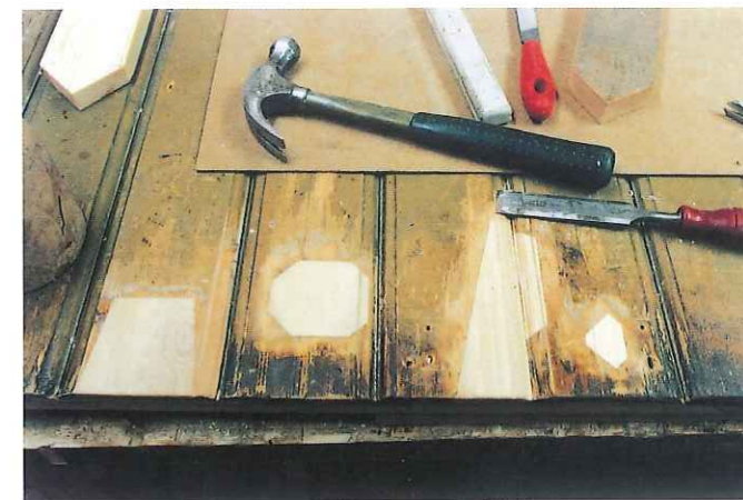
Skadorna har lappats och lagats minutiöst, så att snickerierna kunnat bevaras i så nära autentiskt skeick som det bara går. I ett annat bygge hade kanske hela dörren, eller åtminstone hela brädor i taget, bytts ut.
